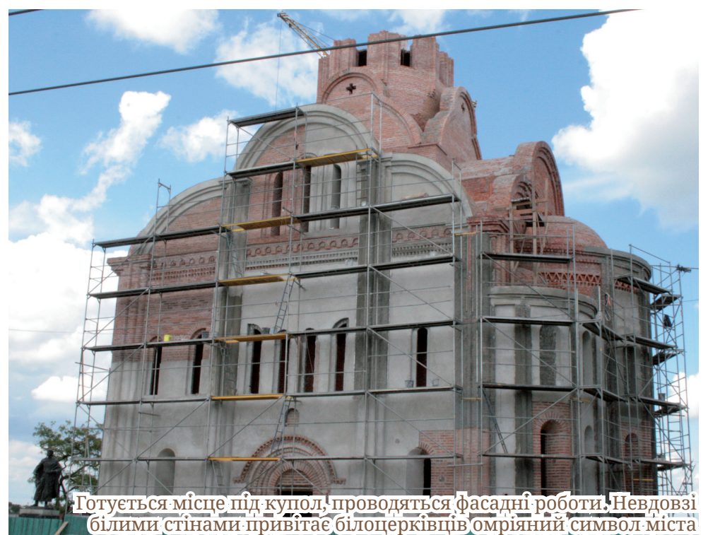
Підходять до завершення загальнобудівельні роботи на Замковій горі. Народжується нова святиня – храм Георгія Победоносця
